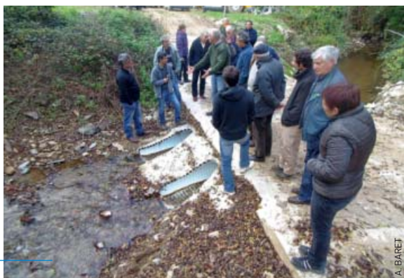
Visite des travaux de desserte réalisés et notamment du radier
