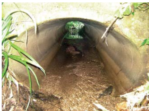
Pont permanent - CRPF - ER
