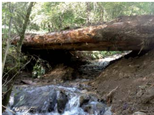
Ponton temporaire à (31) Jurvielle - ONF - TPallec
