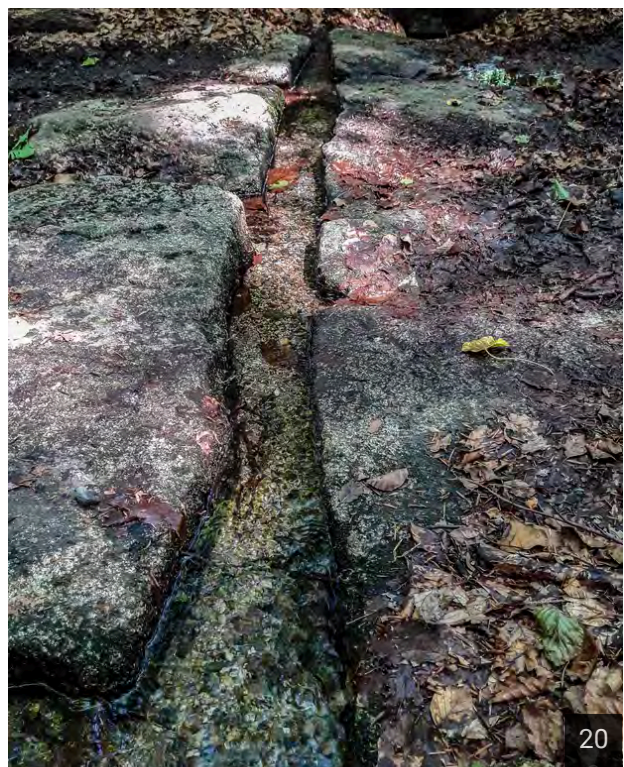
Rigole creusée dans des dalles de granit au niveau d'un passage à gué (Lamontéliarié, Tarn).
