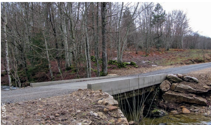
Pont pour les routes forestières
