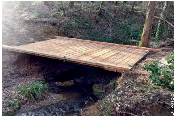
Passages temporaires de cours d'eau lors d'un chantier forestier.
