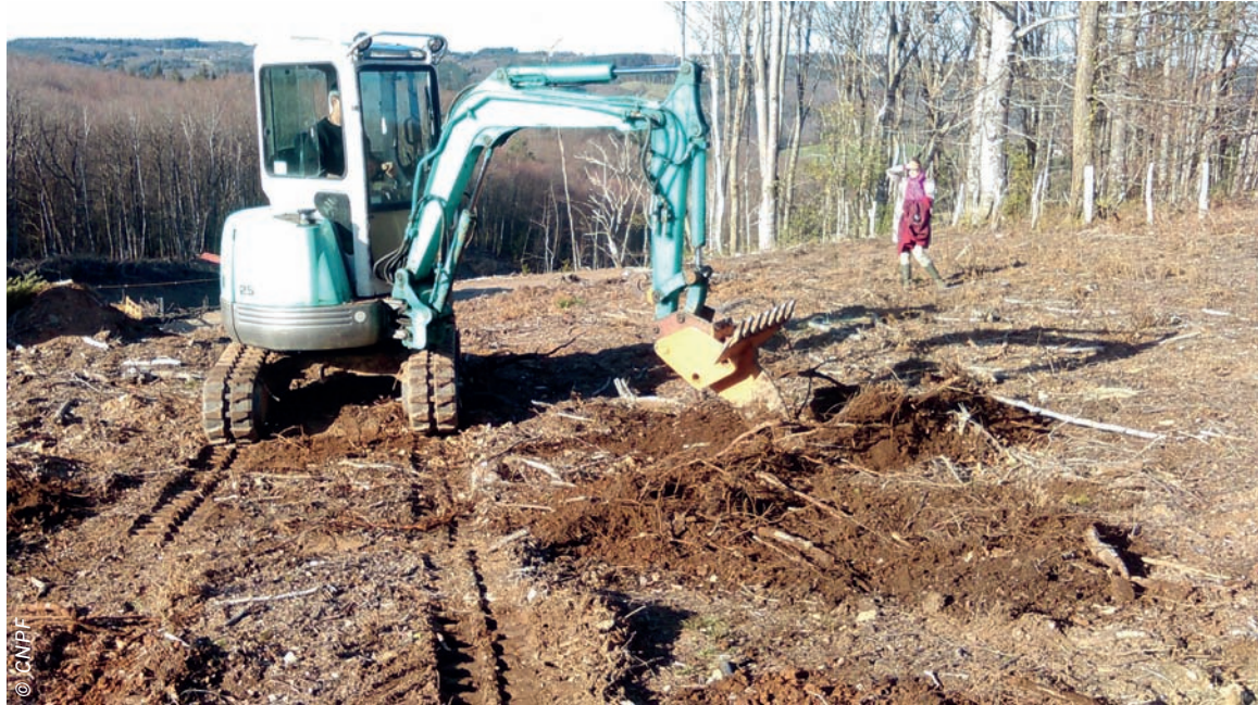
Préparation du sol en potet à la mini-pelle mécanique.
