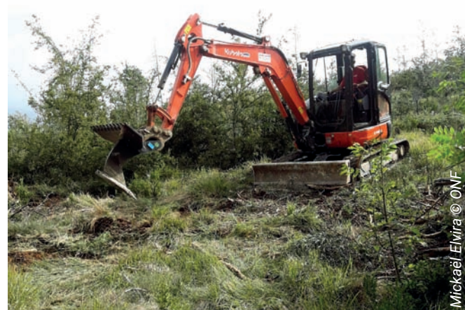
Mini-pelle 5 tonnes avec Dent Becker pour la confection de potet mécanique.
