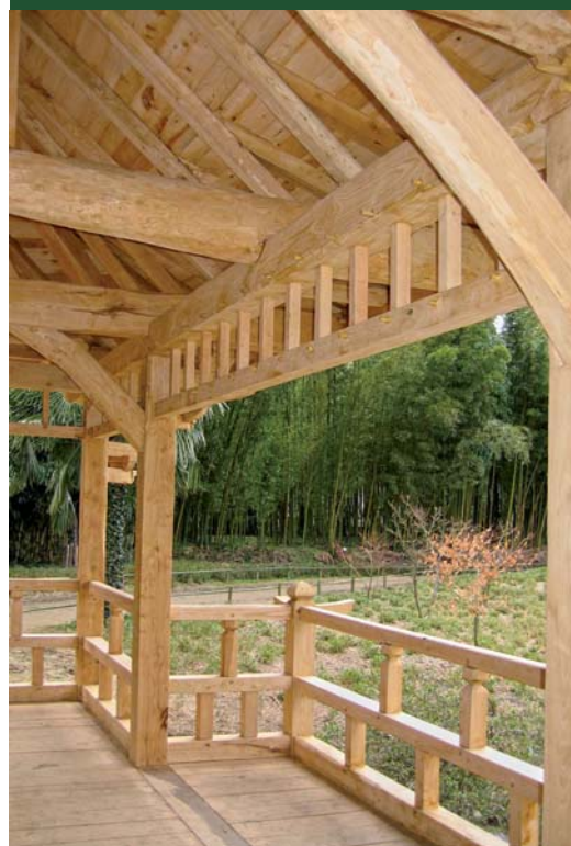
Pavillon japonais à Anduze. Une réalisation en Cèdre (plancher et voligeage) et Châtaignier.
