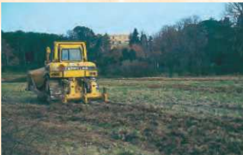
Réalisation d'un sous-solage avec trois dents tirées par un bulldozer.
