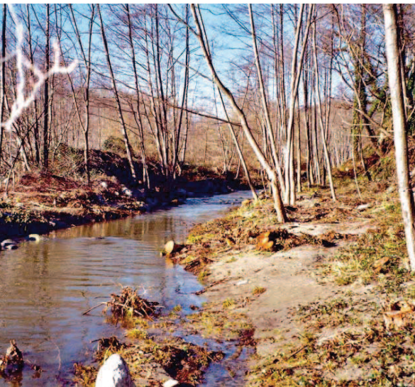
Exploitation pour l'aménagement des rives d'un bras secondaire du Tech
