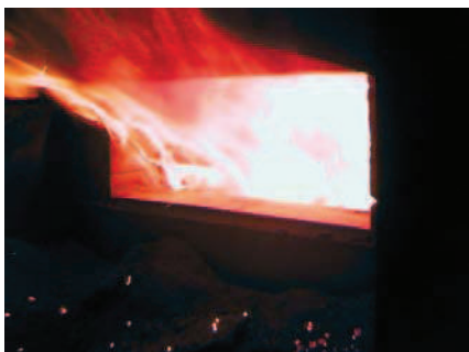
Combustion dans le foyer d'une chaudière
